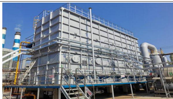
常德公司：处理能力为 48000m 3 /h 的蓄热式废气焚烧炉（RTO）系统及操作记录
