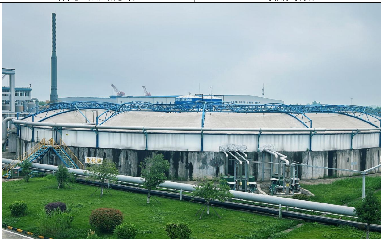
污水站生化池加密封盖
